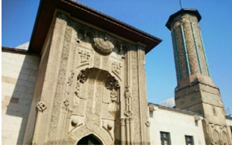
Resim 4: Konya İnce Minareli Medrese Taç Kapısı
